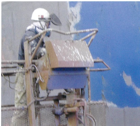
▲乾式ブラスト状況 Dry blast situation
