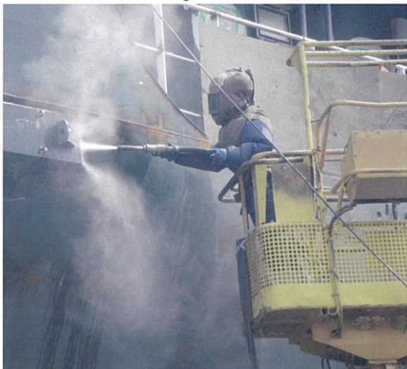
▼混気ジェット 水ブラスト状況<新造> Admission water jet blast situation
