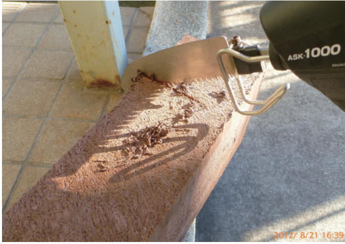
ノコギリ切断 Saw cutting
