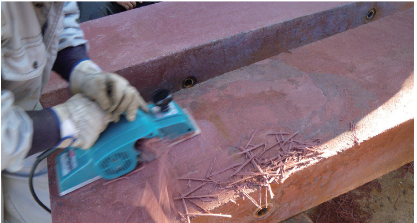
電気カンナ加工状況 Processing in an electric planer
