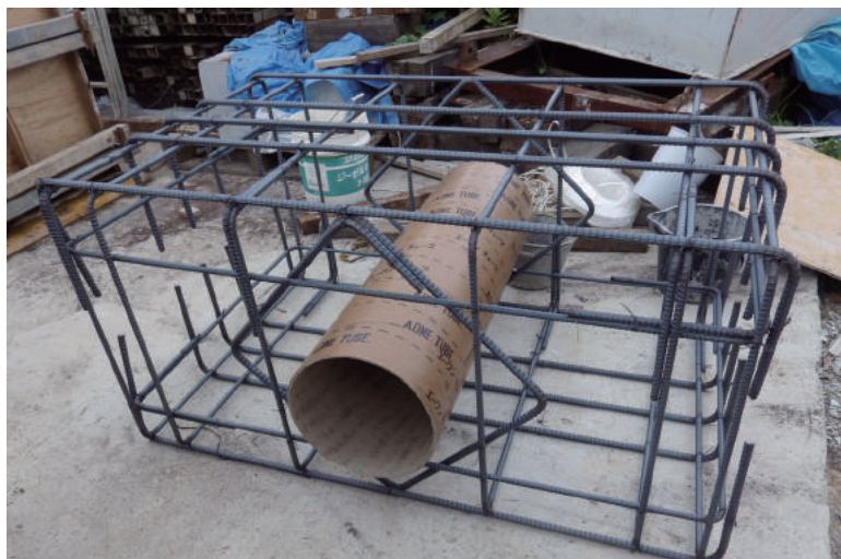
コンクリート盤木製作状況(丸穴はレベル確認用) Concrete Artificial wood board production situation(Round hole is for level check)
